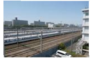
JR東海道新幹線大井車両基地
