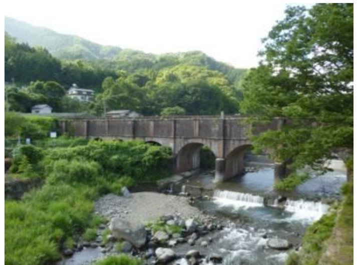
駒橋発電所 落合水路橋
