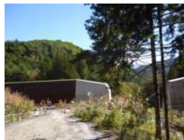
ダムの建設現場
