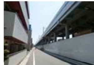
京急羽田空港線沿線
