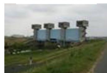
新岩淵水門(青水門)
