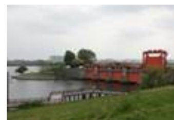
岩淵水門(赤水門)
